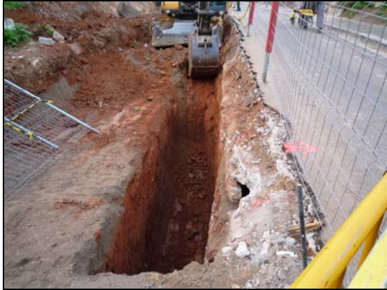
FOTO 5. Realització de la rasa per el col·lector nou
