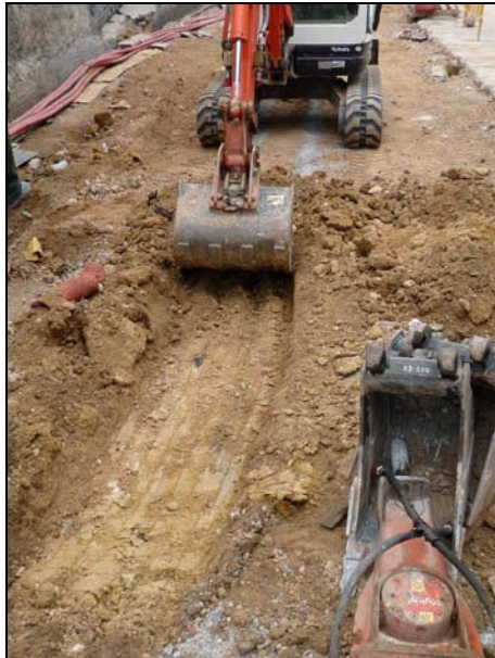
FOTO 9. Obertura de rasa per serveis
