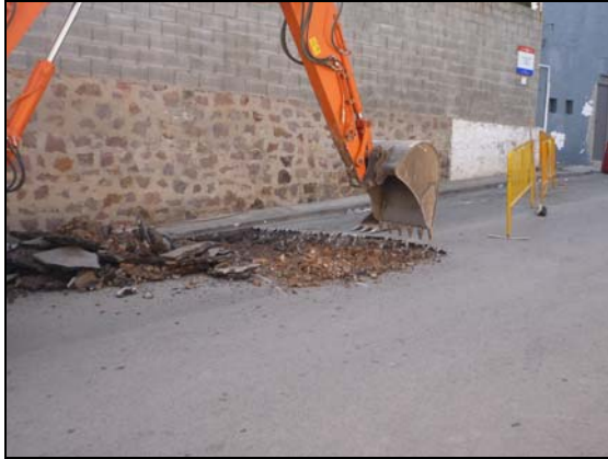
FOTO 1. Trencament del asfalt amb màquina
