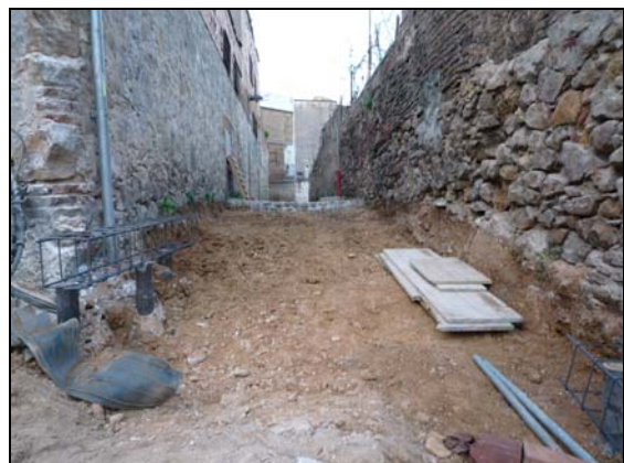
FOTO 12. Rebaix al passatge antic de València
